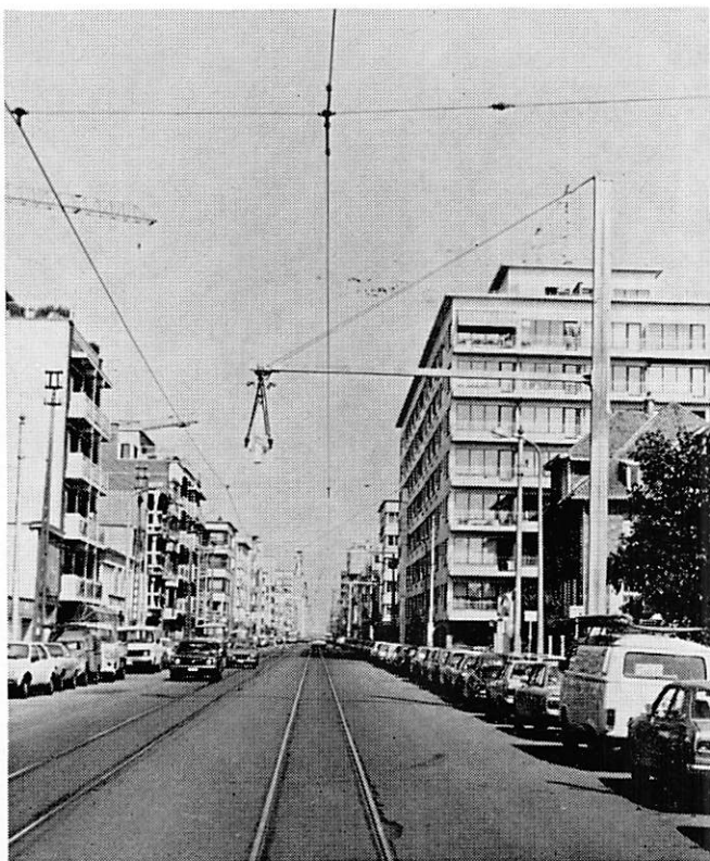
Middelkerke : installation nouvelle caténaire. (Photo W. Hoste - août 78) Middelkerke : aanbrengen van nieuwe bovenleiding. (Foto W. Hoste, augustus 78)
