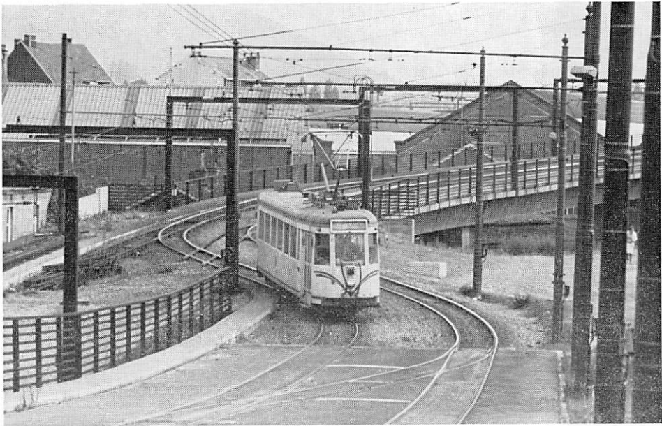
Charleroi - ligne 65 quittant l'assiette du futur prolongement sous le Viaduc à Charleroi. (Photo W. Hoste le 20/6/78) Charleroi - lijn 65, bij het verlaten van de bedding van de toekomstige verlenging onder de viadukt te Charleroi. (Foto W. Hoste, 20-6-78)
